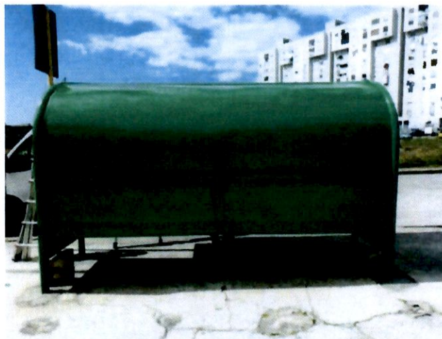
FOTO DOPO L'INTERVENTO
