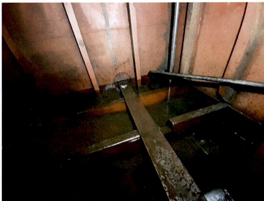
14. prova idrostatica per verifica saldature nella cassa gasolio di dritta
