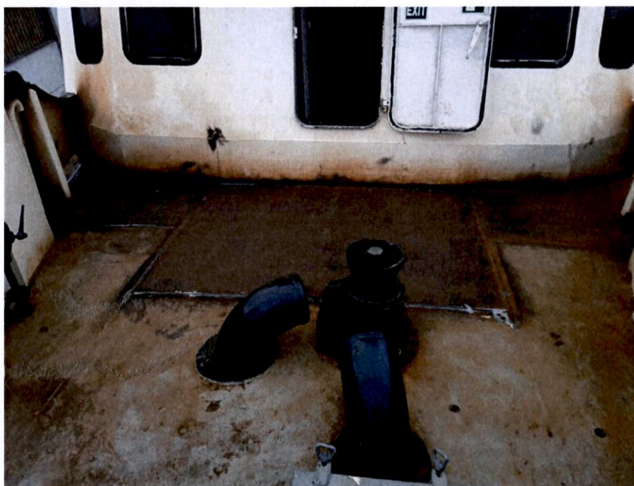
4. completamento saldature lamiere posto di manovra prua
