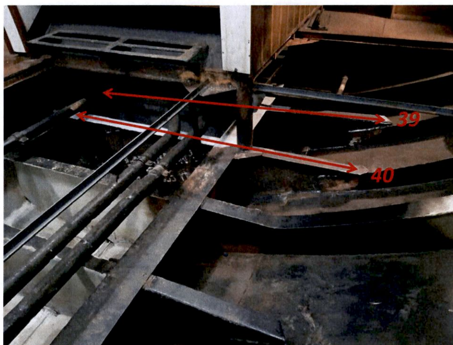
23. in evidenza sostituzione madieri e paramezzale sinistro - locale bar lato sinistro
