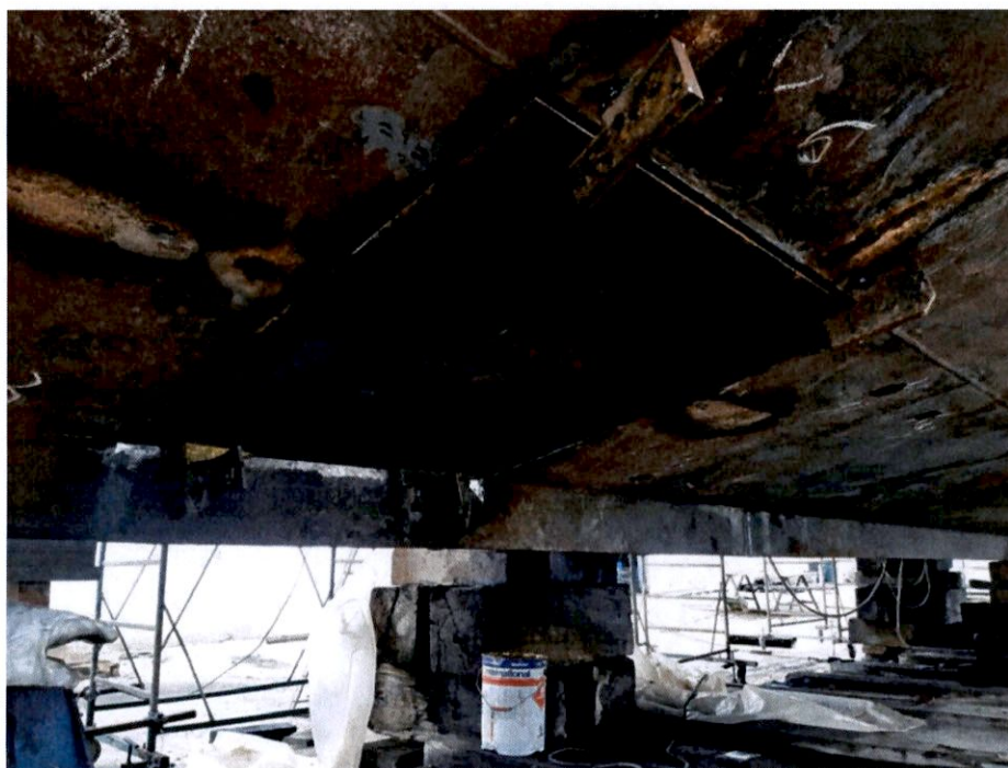
25. fasi preparatorie a posizionamento inserto lamiera
