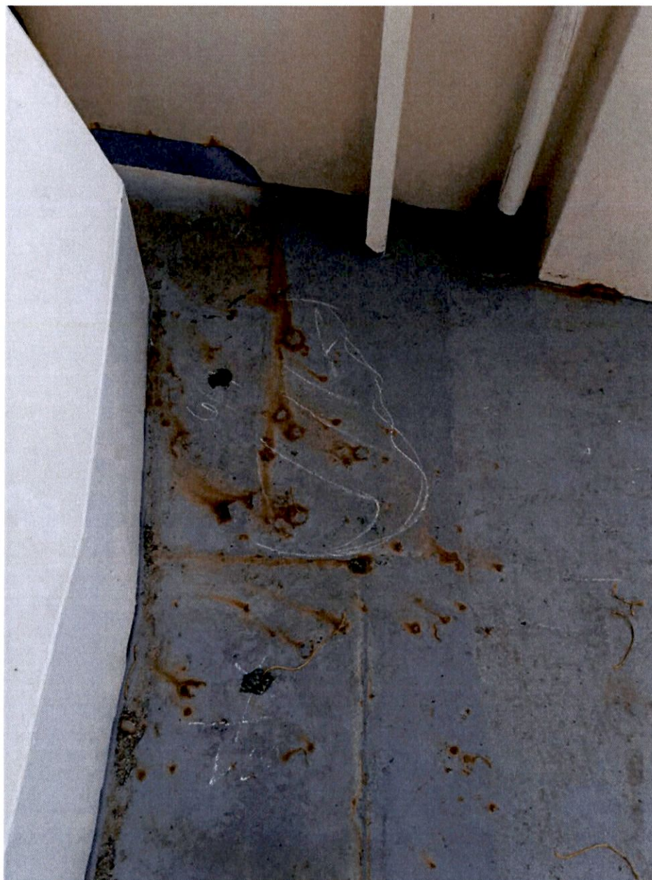
1. lamiera posto di manovra prua - corrosione diffusa e passante
