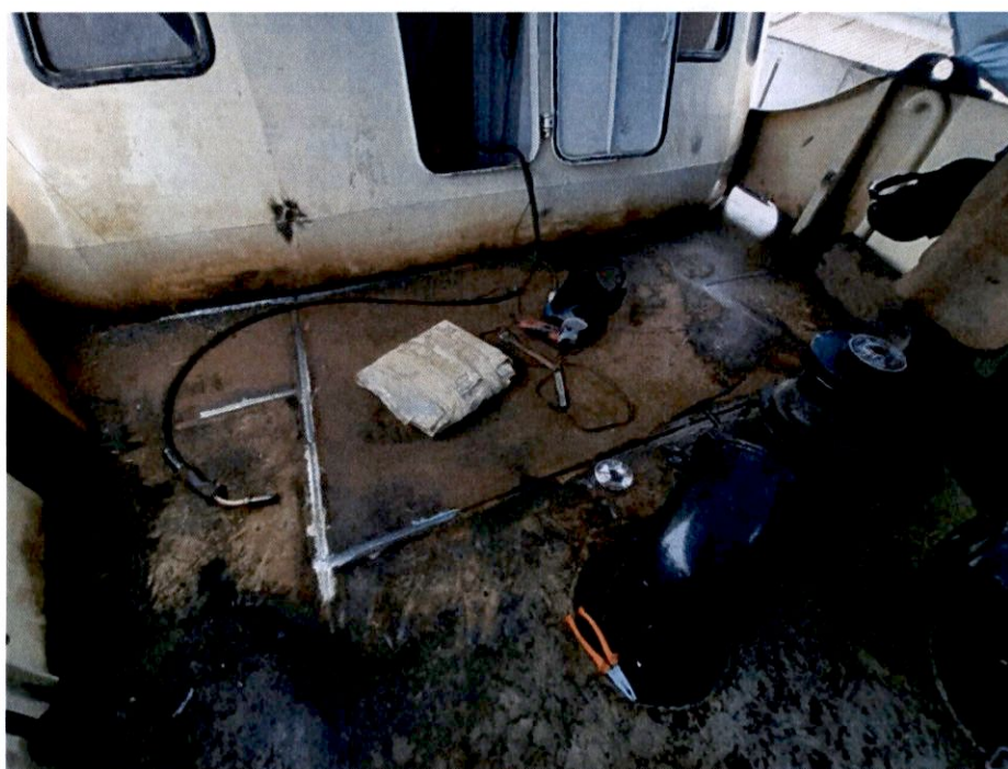
3. fasi finali saldatura lamiera posto di manovra prua
