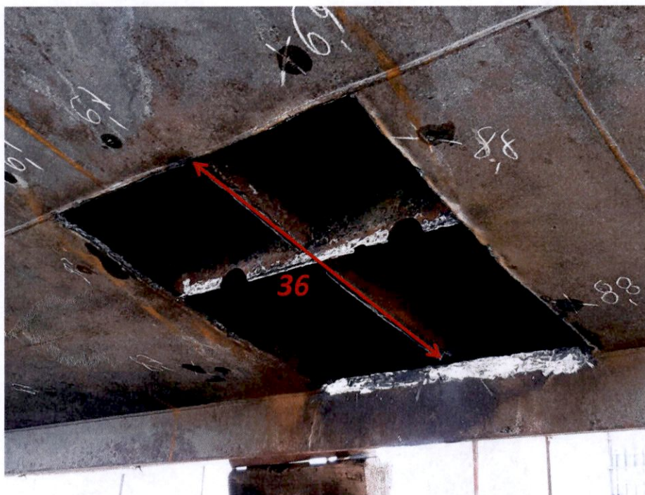
16. apertura su primo corso di fasciame lato dritto locale bar - ordinata n. 36
