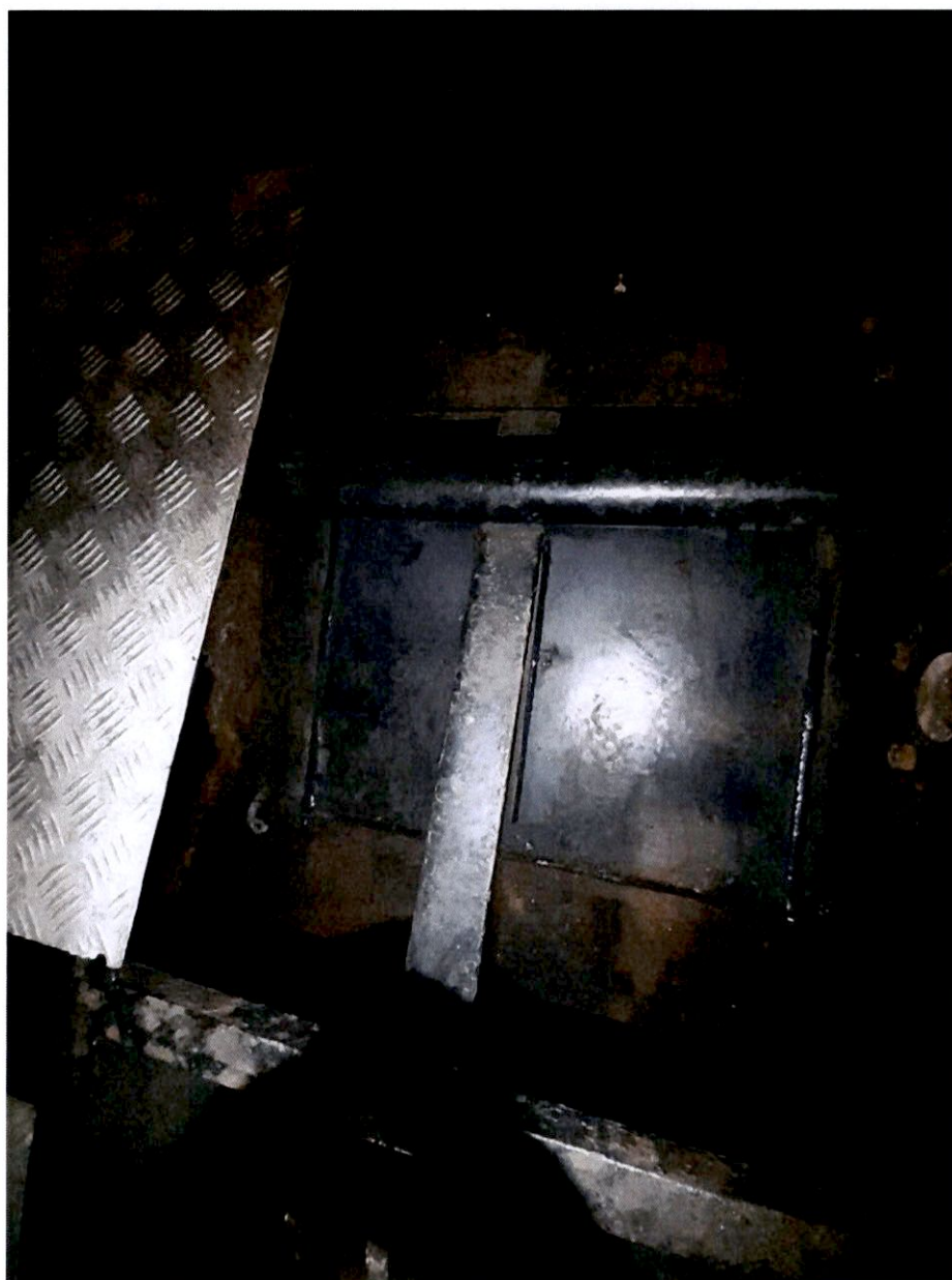
17. completamento saldature lamiera locale bar lato dritto – vista dall'interno
