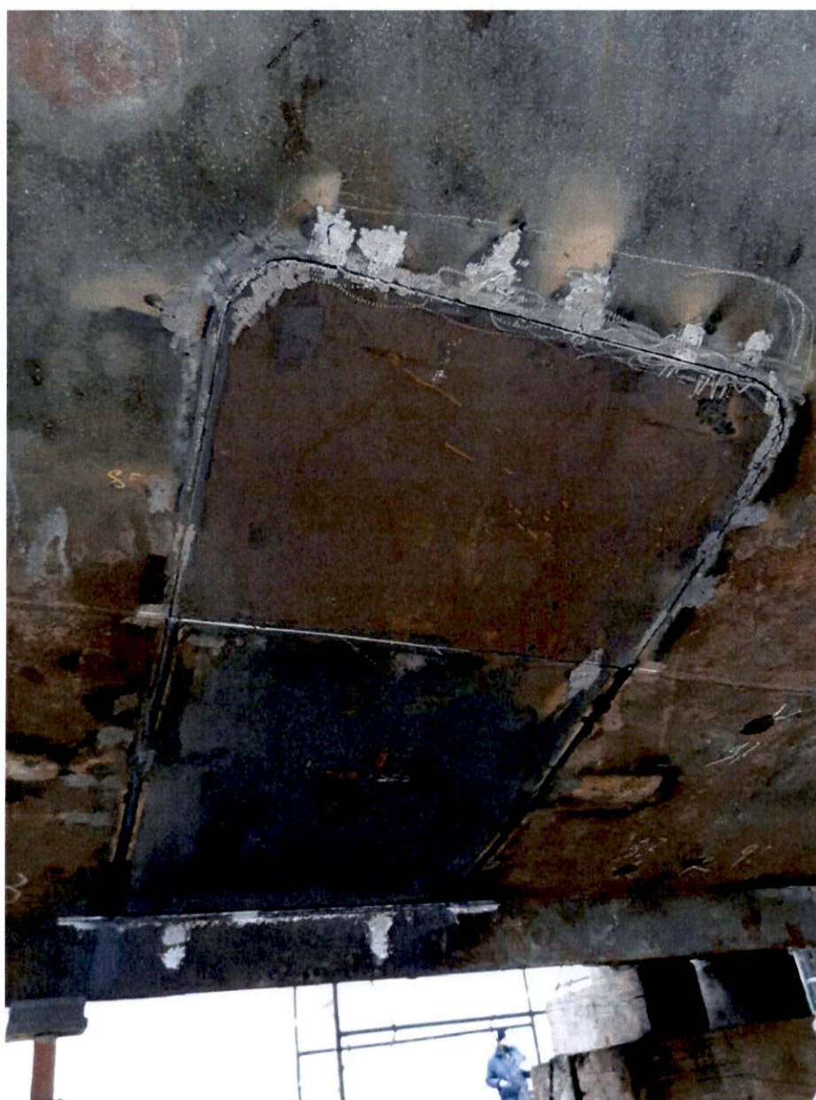
29. fasi preparatorie a saldatura finale su inserto lamiera secondo corso di fasciame locale bar lato sinistro
