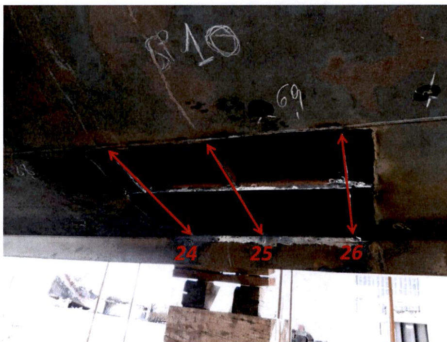
9. apertura su primo corso di fasciame tra sala macchina e locale casse - ordinate n. 24, 25 e 29
