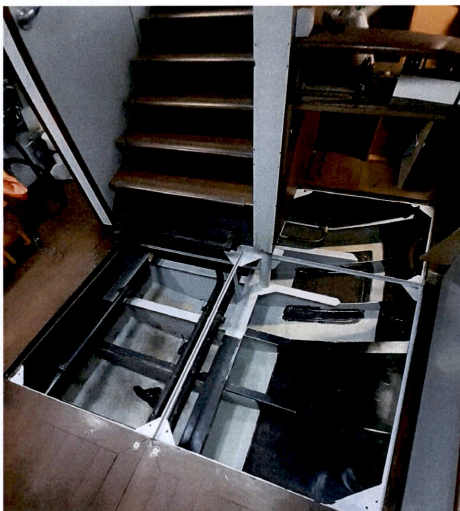
28. visione d'insieme di madieri, paramezzale e lamiere primo e secondo corso di fasciame – vista dall'interno
