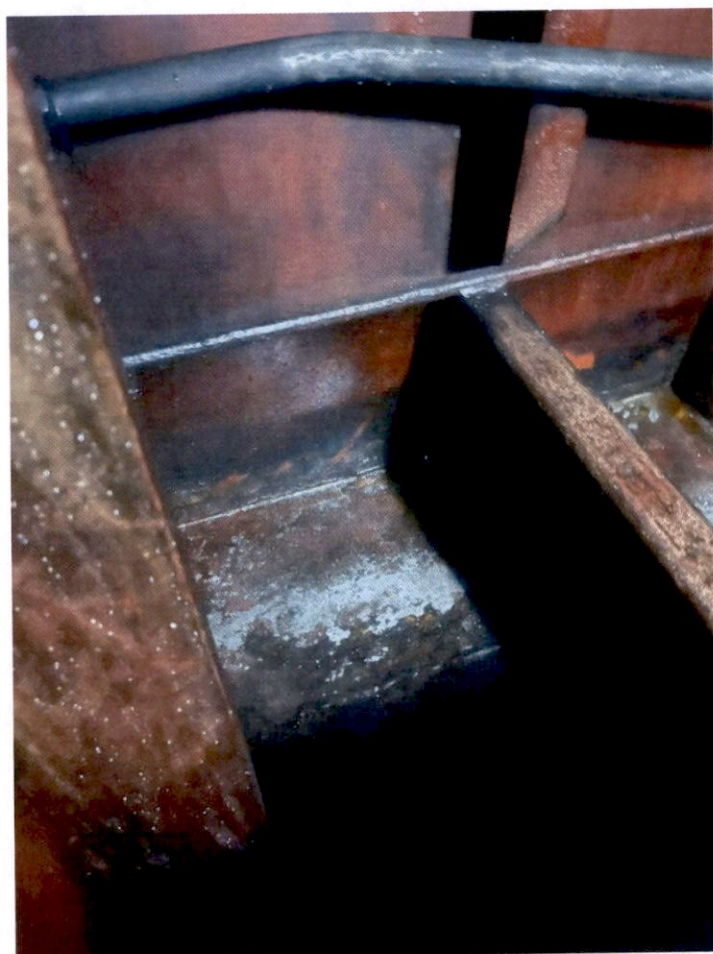
parte centro-prua cassa principale gasolio sinistra dopo la bonifica
