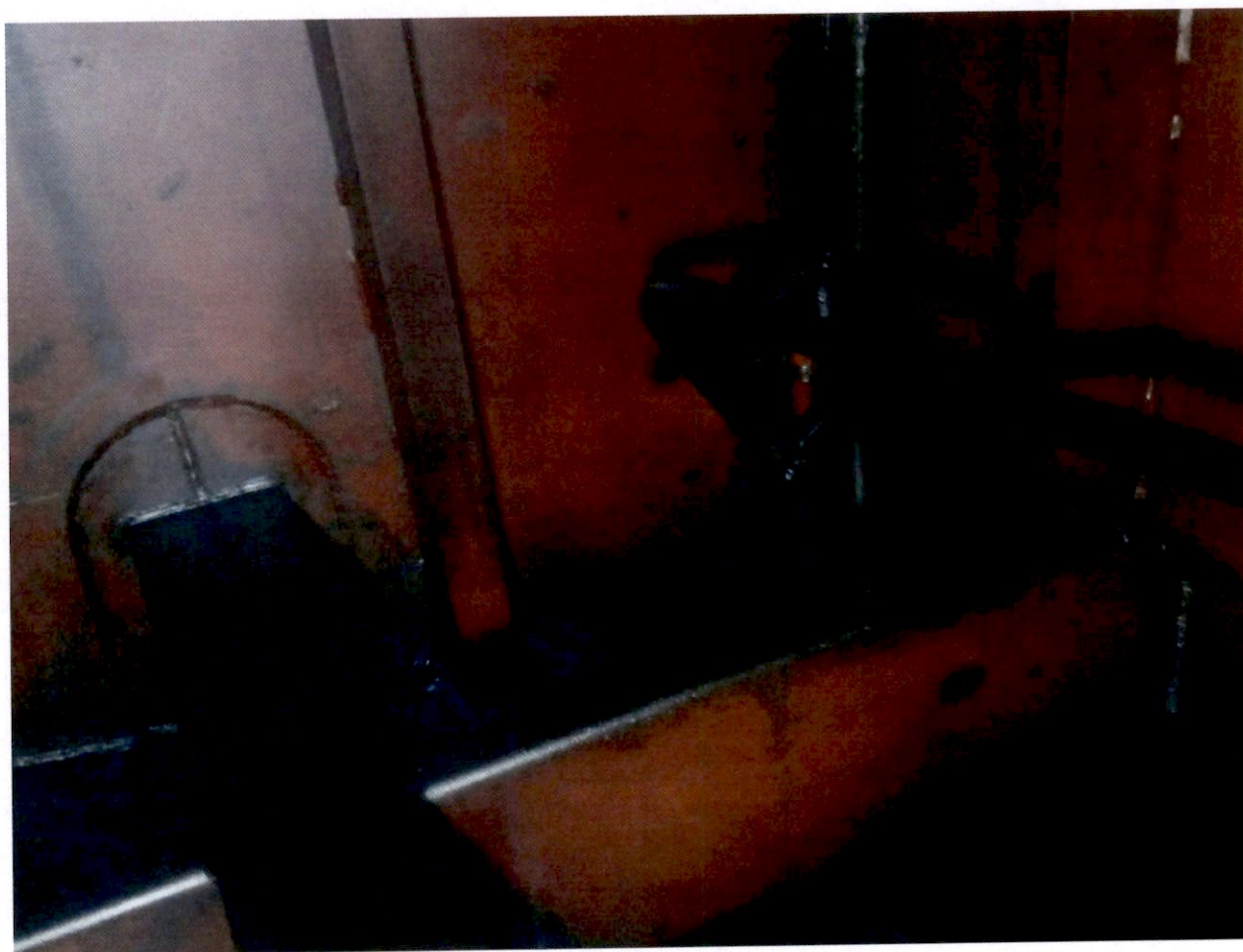
cassa principale gasolio dritta prima della bonifica
