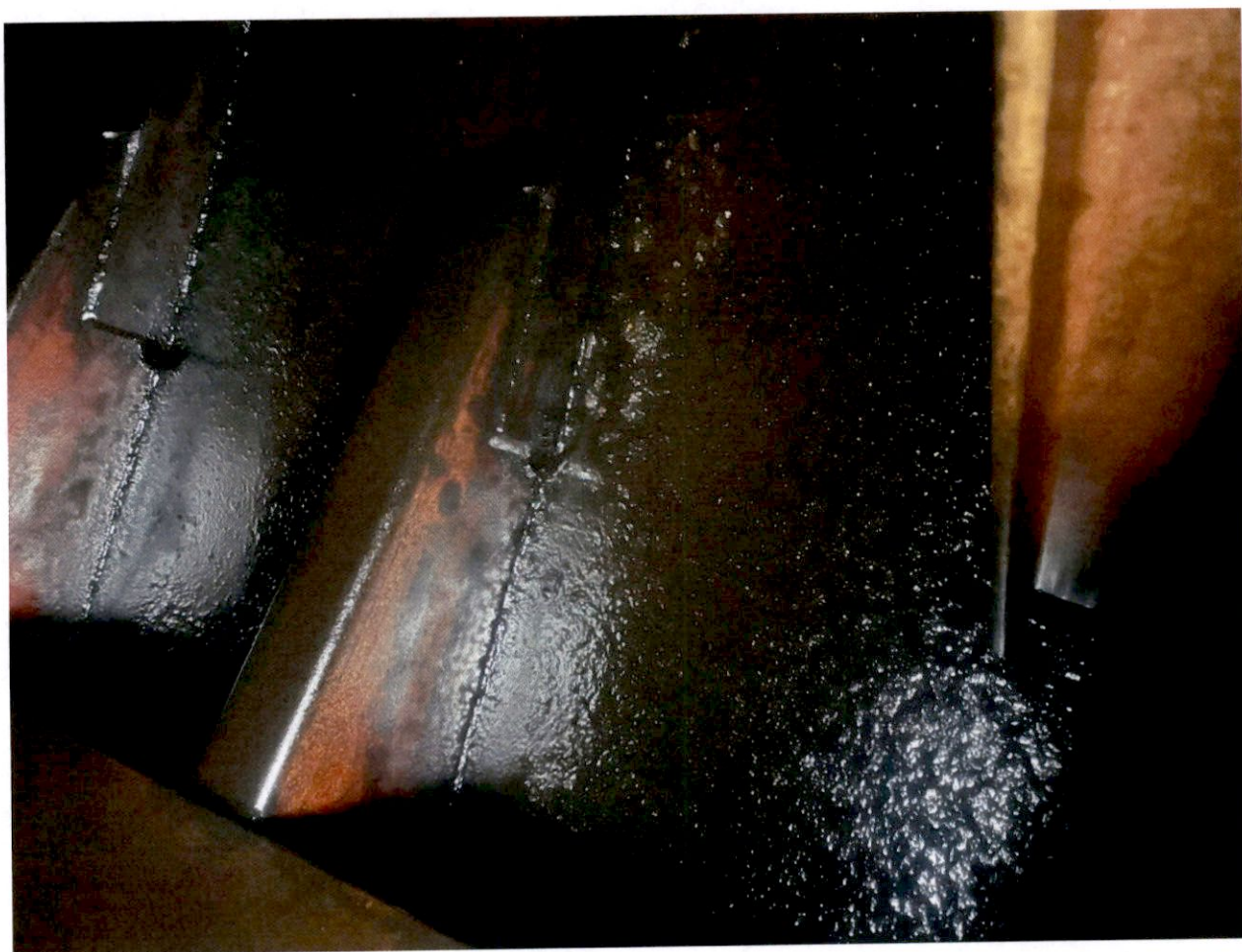
paratia scafo cassa principale sinistra con ingente deposito di morchie prima della bonifica
