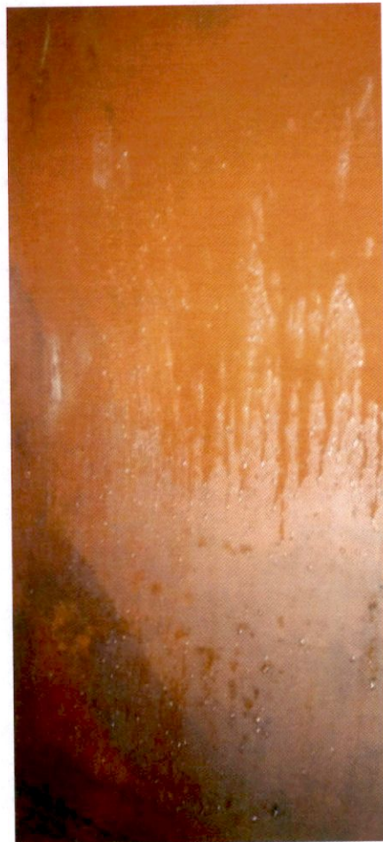
particolare paratia cassa principale gasolio dritta dopo la bonifica
