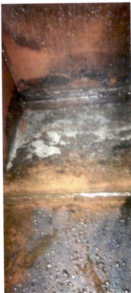
parte centro-prua cassa principale gasolio dritta dopo la bonifica
