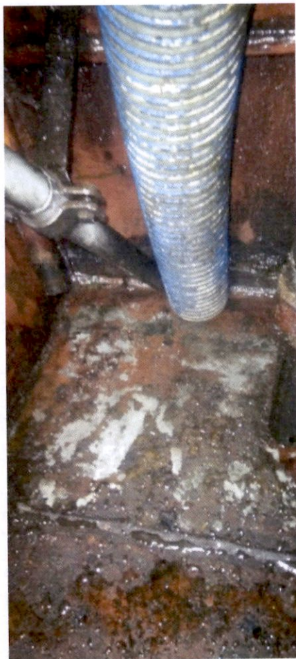
parte centro-poppa cassa principale gasolio dritta dopo la bonifica
