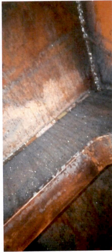
strutture longitudinali a scafo cassa principale gasolio dritta dopo la bonifica
