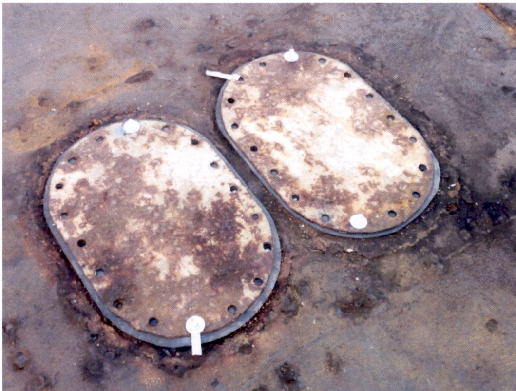
Passi d'uomo lato "Gambero" si inizia il ripristino dei prigionieri chiusura
