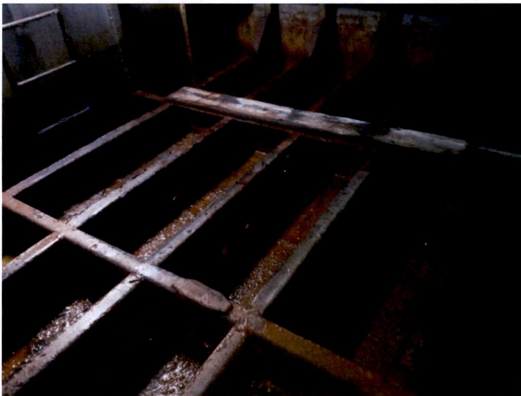
Presenti nei "frames" piccole quantità di fanghiglia / placche di ruggine
