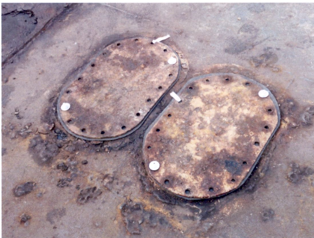
Passi d'uomo lato "ponte di pietra" si inizia il ripristino dei prigionieri chiusura
