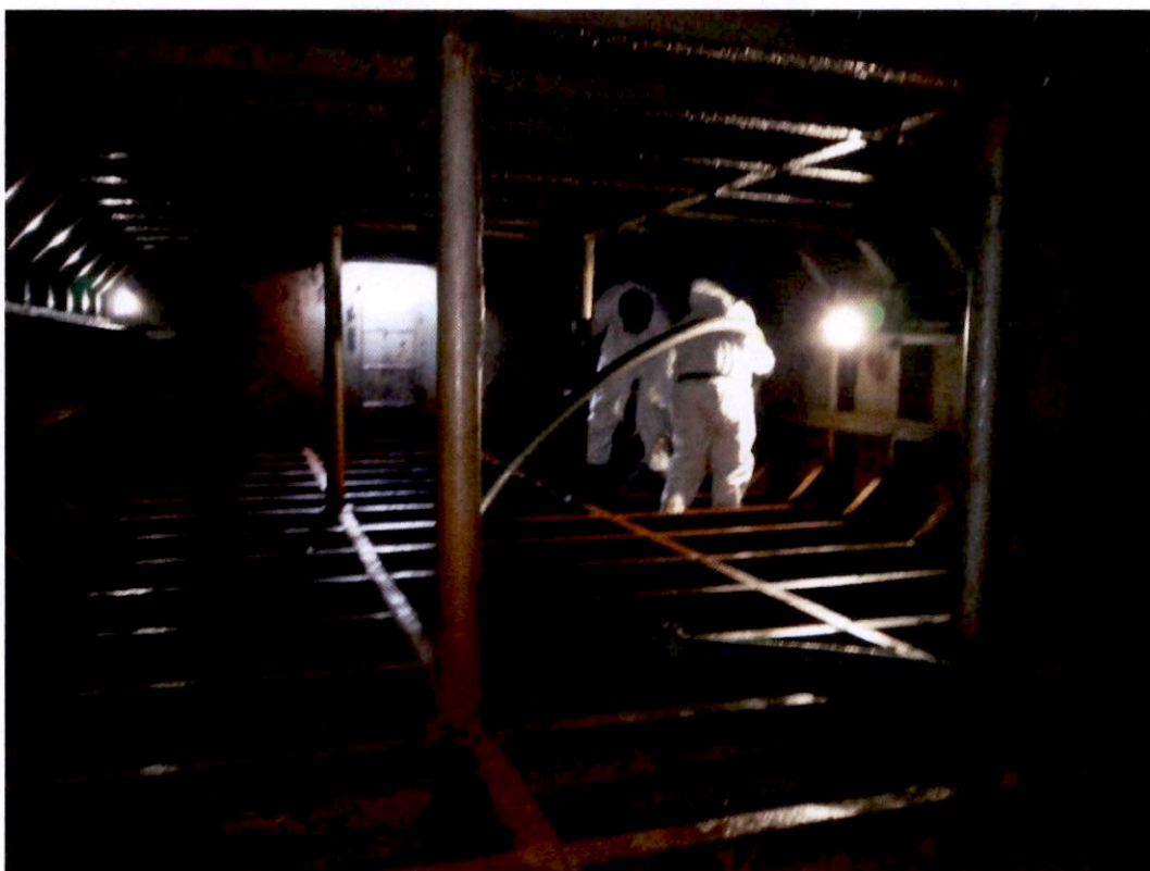
Continua l'aspirazione a favore di pendenza nel compartimento centrale
