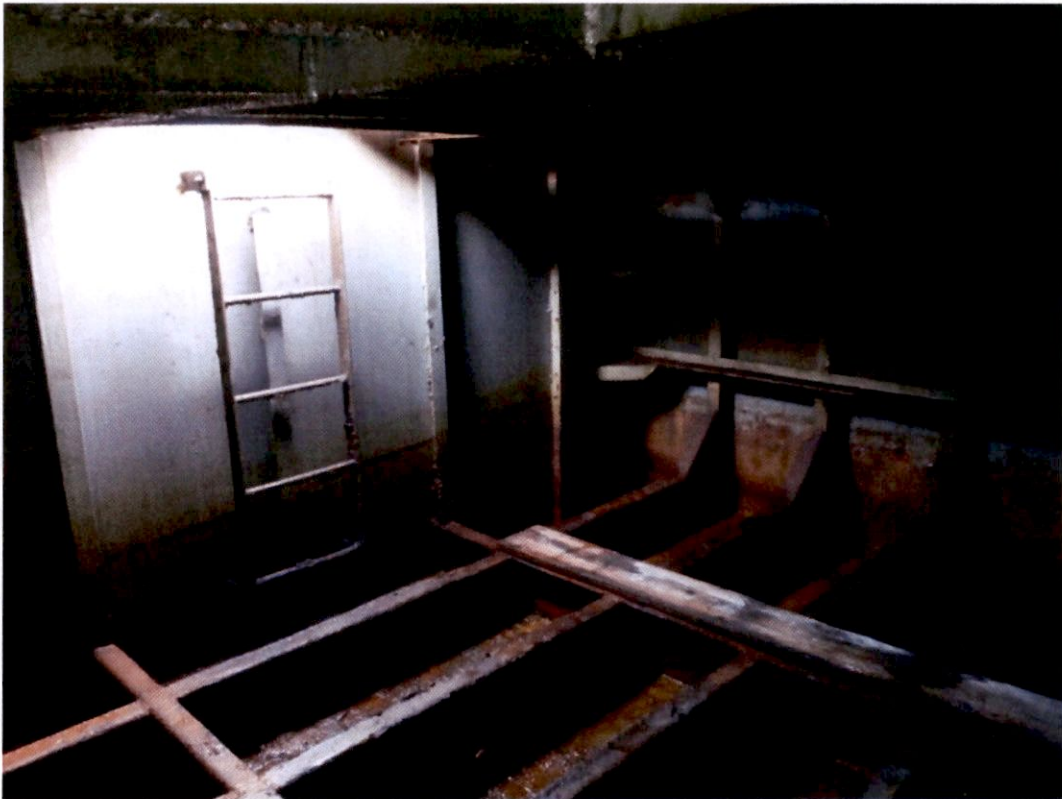
Prosciugamento del compartimento lato "ponte di pietra"
