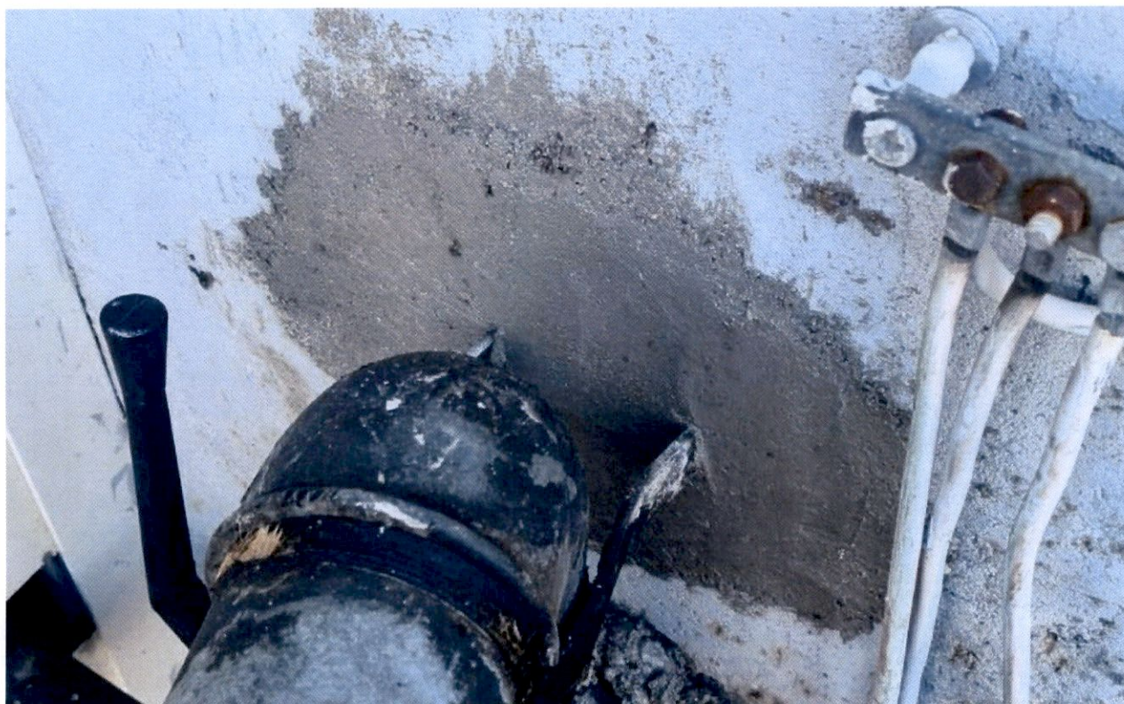
Fig. 4 – Varco di alloggiamento tubazione in cemento dopo dell'attività
