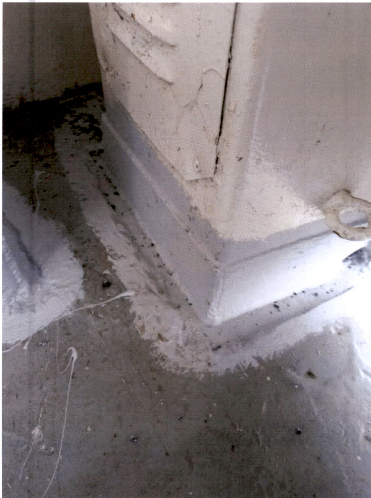
particolare condotta di aerazione lato dr del locale agghiaccio timone raddoppio di lamiera con zoccolatura spessore 8 mm - poppavia
