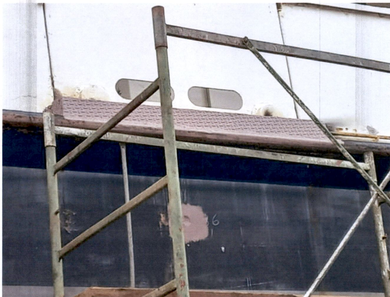
particolare rampa d'accesso in lamiera bugnata
