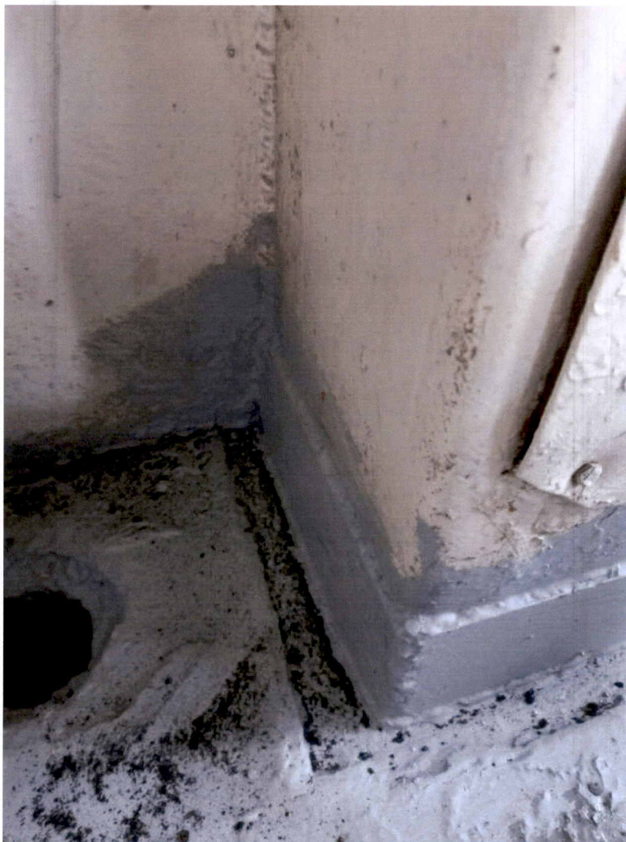
particolare condotta di aerazione lato dr del locale agghiaccio timone raddoppio di lamiera con zoccolatura spessore 8 mm - pruavia
