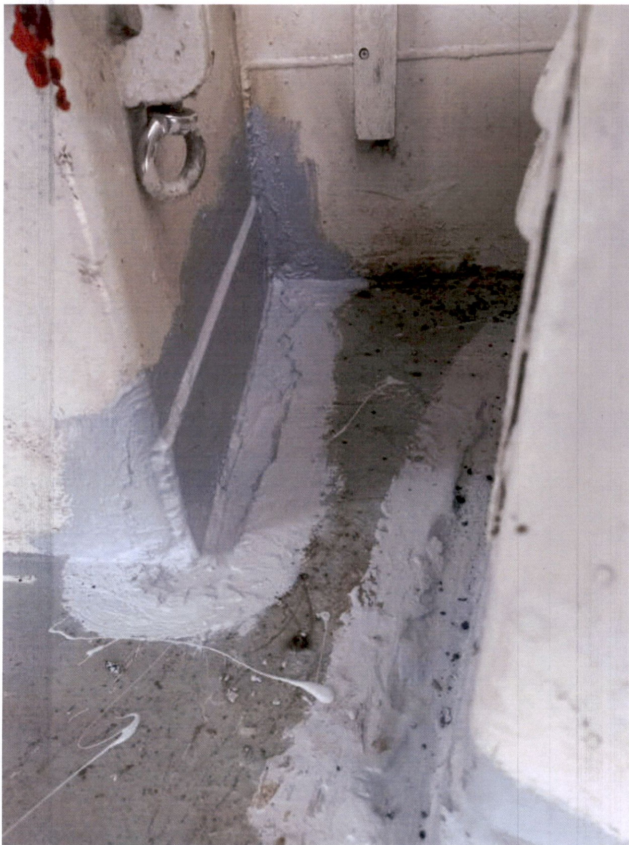
particolare mastra portellone d'accesso al locale agghiaccio timone raddoppio di lamiera con zoccolatura spessore 8 mm
