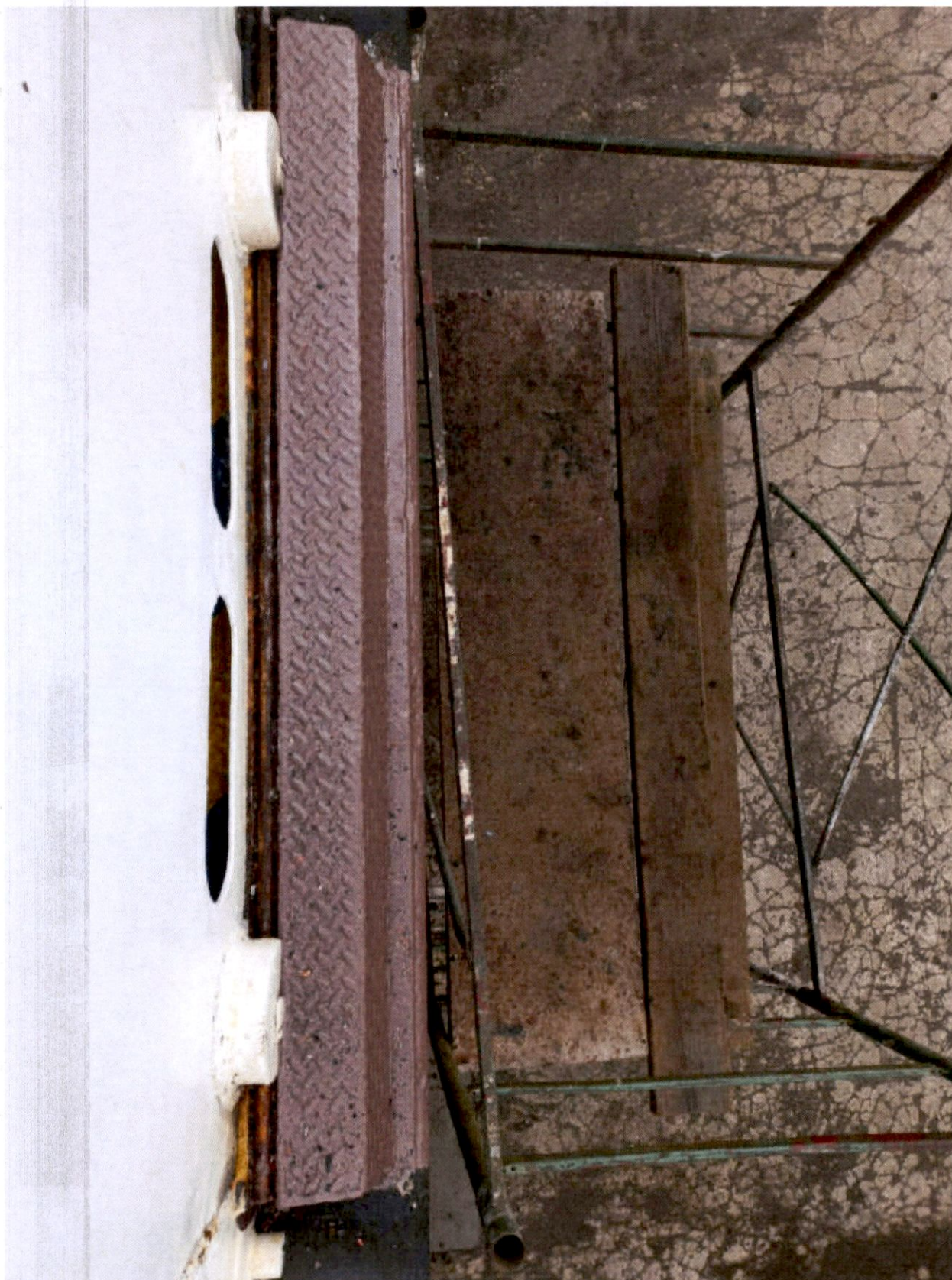
vista dall'alto - lamiera bugnata verticale, sostituita con tecnica ad inserto
